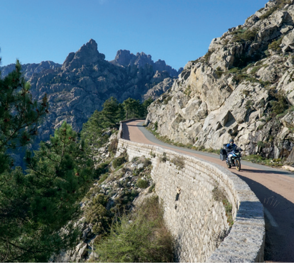
Gut gemauert: Typischer Straßenbau auf Korsika.
